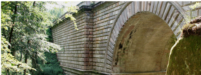
Brückkanal (08.04.2016, VGN © VGN GmbH)
